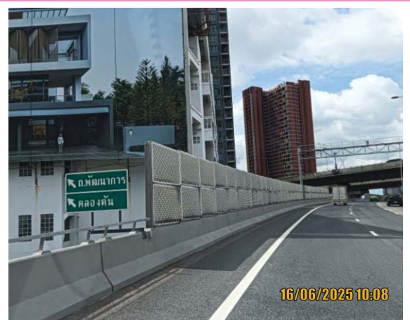
รูปที่ 3.2-8 กำแพงกันเสียงบริเวณ เคที อพาร์ทเมนต์ (กม. 5+800B)
