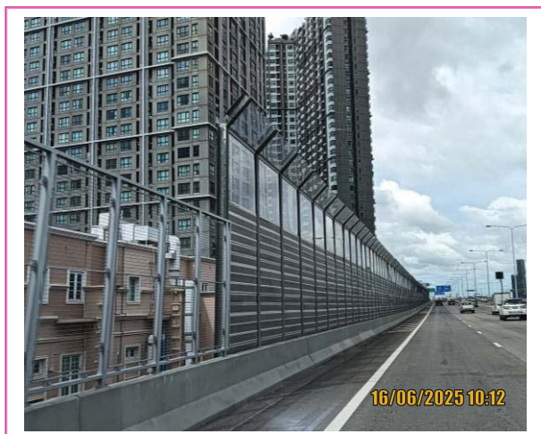
รูปที่ 3.2-3 กำแพงกันเสียงบริเวณคอนโด The Base (กม. 1+800B)
