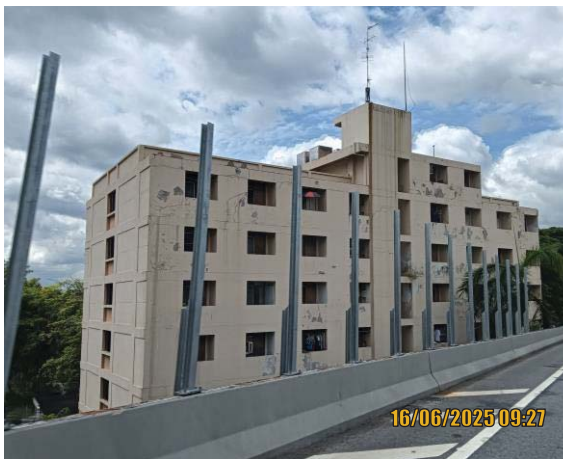
รูปที่ 3.1-10 กำแพงกันเสียง บริเวณศิริเพียร อพาร์ทเมนต์ (กม. 5+400B) (อยู่ระหว่างรื้อถอน ซึ่งมีแผนการปรับปรุงกำแพงกันเสียง กำหนดซ่อมแซมเสร็จสิ้นภายในเดือน ก.ค. 2568)
