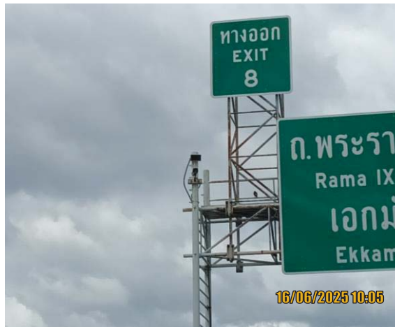
รูปที่ 3.2-13 กล้องโทรทัศน์วงจรปิดดูสภาพจราจร
