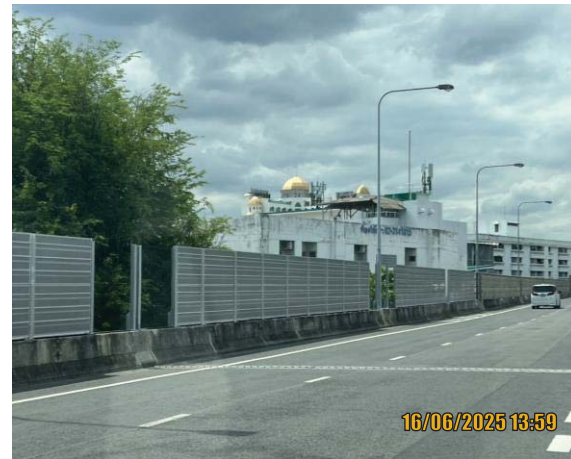
รูปที่ 3.1-11 กำแพงกันเสียง บริเวณสมานมิตร อพาร์ทเมนต์ (กม. 5+300A) (อยู่ระหว่างรื้อถอน ซึ่งมีแผนการปรับปรุงกำแพงกันเสียง กำหนดซ่อมแซมเสร็จสิ้นภายในเดือน ก.ค. 2568)
