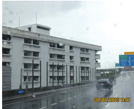
รูปที่ 3.1-9 กำแพงกันเสียง บริเวณมูลนิธิเพื่อศูนย์กลางอิสลาม (กม. 5+100A) (อยู่ระหว่างรื้อถอน ซึ่งมีแผนการปรับปรุงกำแพงกันเสียง กำหนดซ่อมแซมเสร็จสิ้นภายในเดือน ก.ค. 2568)
